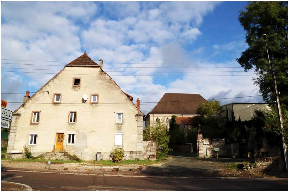
Fig. 5 – Vue du site actuel du Prieuré prise depuis l'ouest
